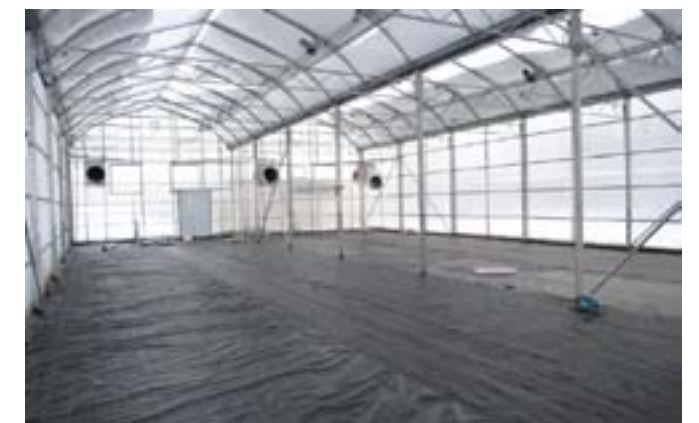
Photo: nouvelles serres
